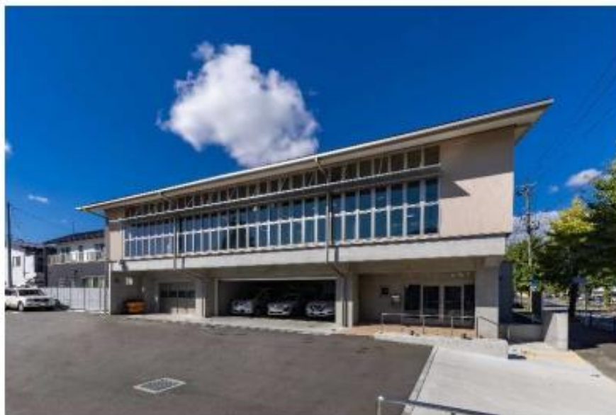
福島県須賀川土木事務所庁舎
