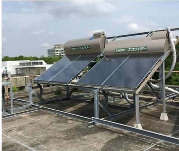
図 1.3-1 密閉型太陽熱温水器\_直圧式（建築研究所における NEDO 実証実験より）
