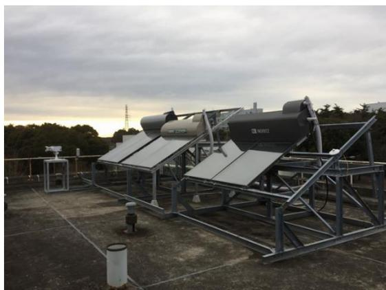
図 1.2-1 開放型太陽熱温水器（建築研究所における NEDO 実証実験より）
